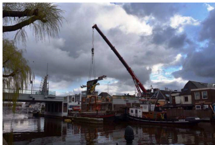
Eerste fase terugplaatsing bruggdelen Julianabrug
