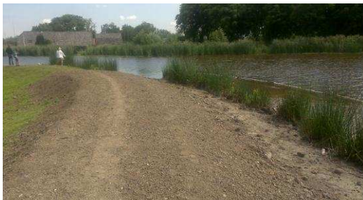
Aanleg van natuurvriendelijke oever bij kadewerk
