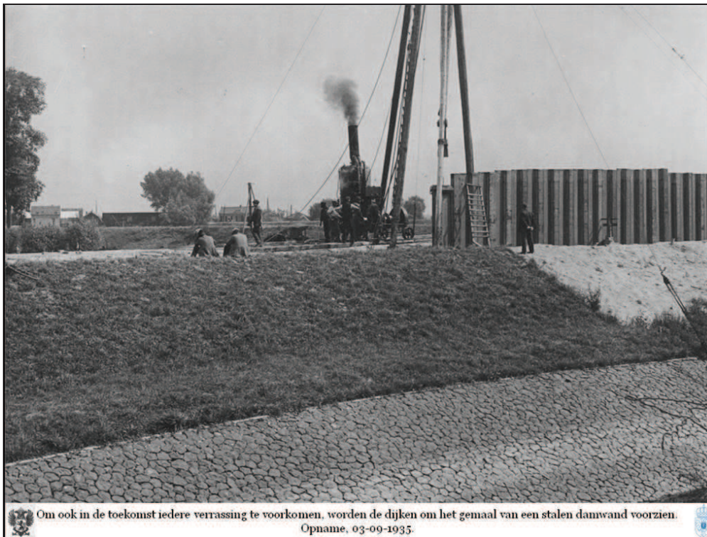
Figuur 3-1 Foto van aanleg gemaal Mr. P.A. Pijnacker Hordijk
